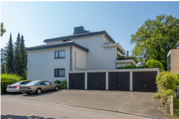
Ansicht mit Garagen
