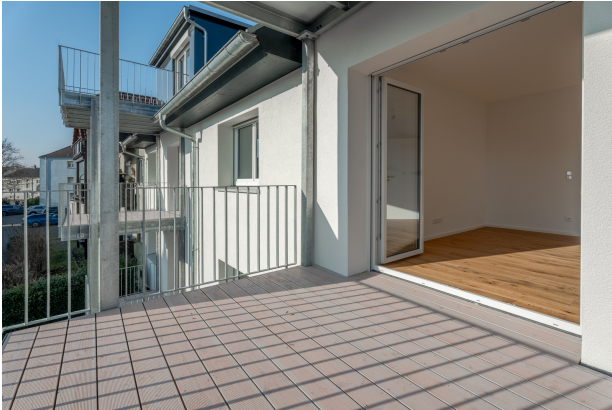
Balkon mit Esszimmer OG links
