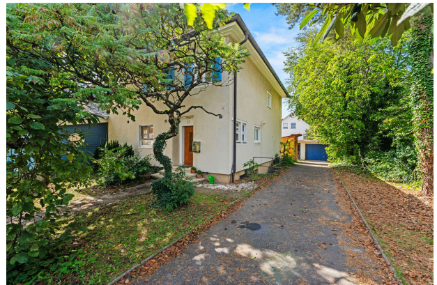
Ansicht mit Garage
