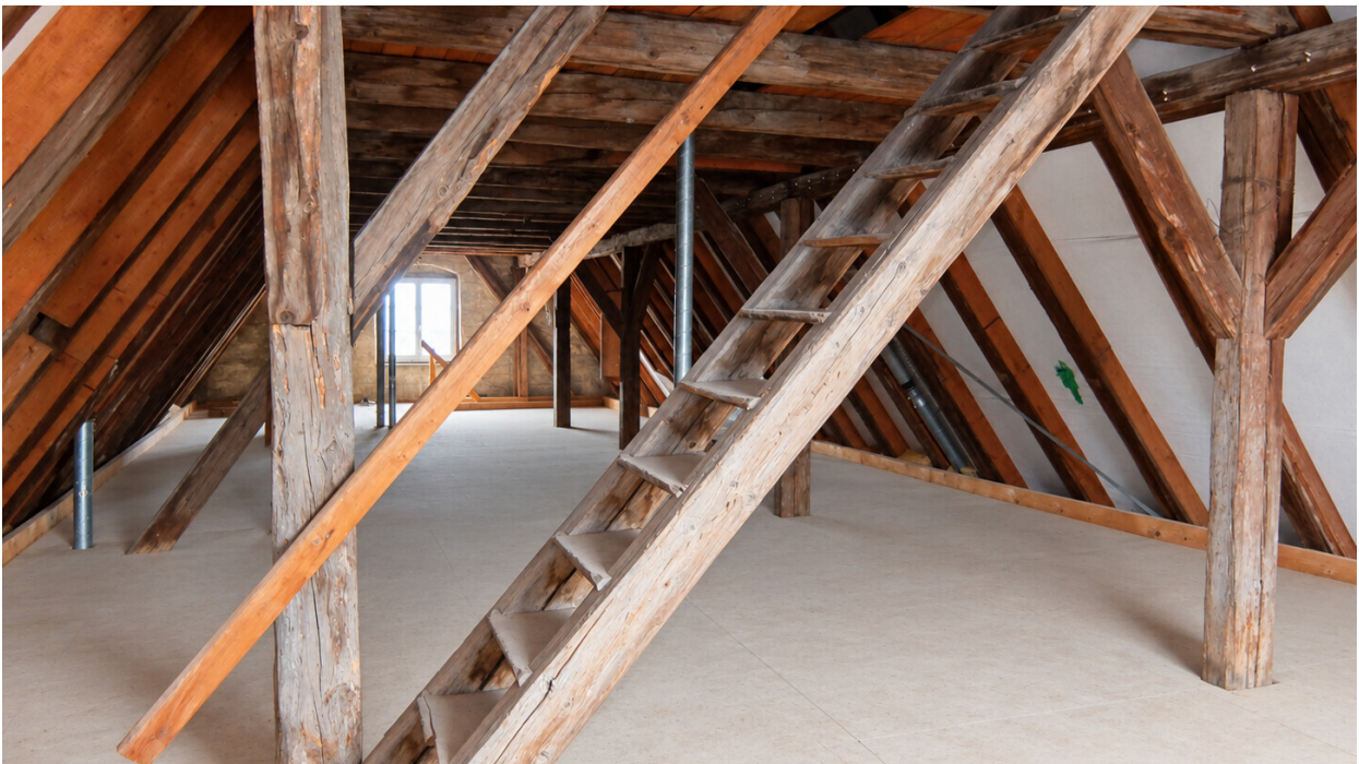
Speicherraum mit Aufgang zum Dachspitz
