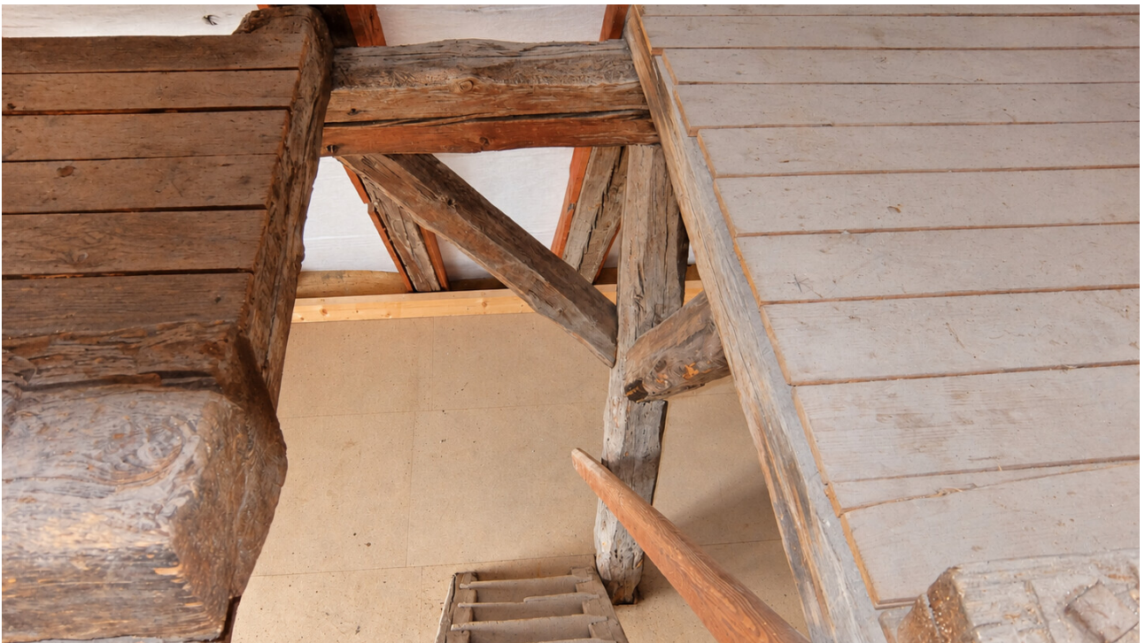
Speicher Aufgang zum Dachspitz
